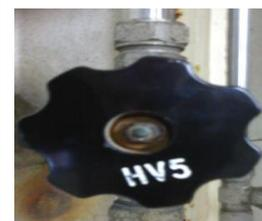
9) Abrir válvula de alimentación de aire al equipo de control VB3 o válvula de paso, línea de tubería verde localizada atrás del equipo del lado izquierdo (girar hacia abajo).
